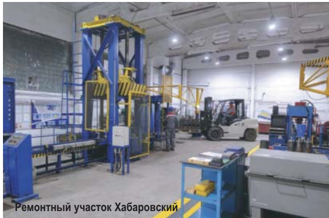
Ремонтный участок Хабаровский
